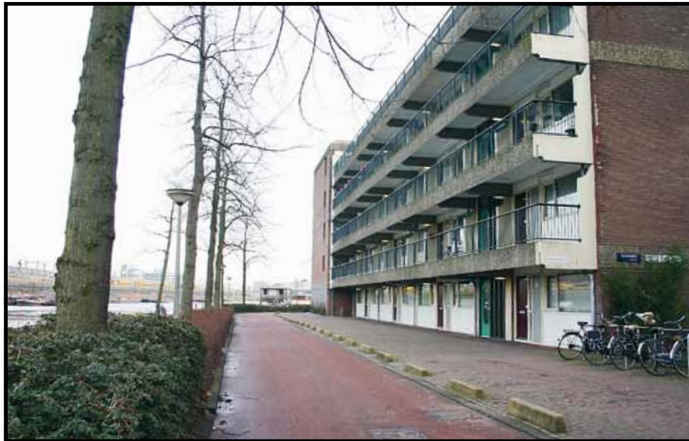
Linksboven en -onder: Marinierskade, gemengd complex Rochdale. Rechts: toekomstig gemengd complex van Stadgenoot, Geldersekade.
